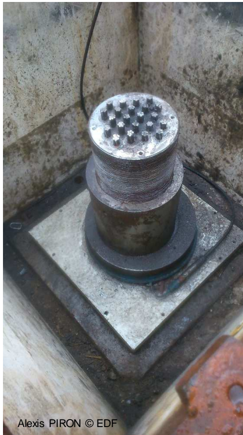
Tête démontable nécessitant un « déclavetage »
