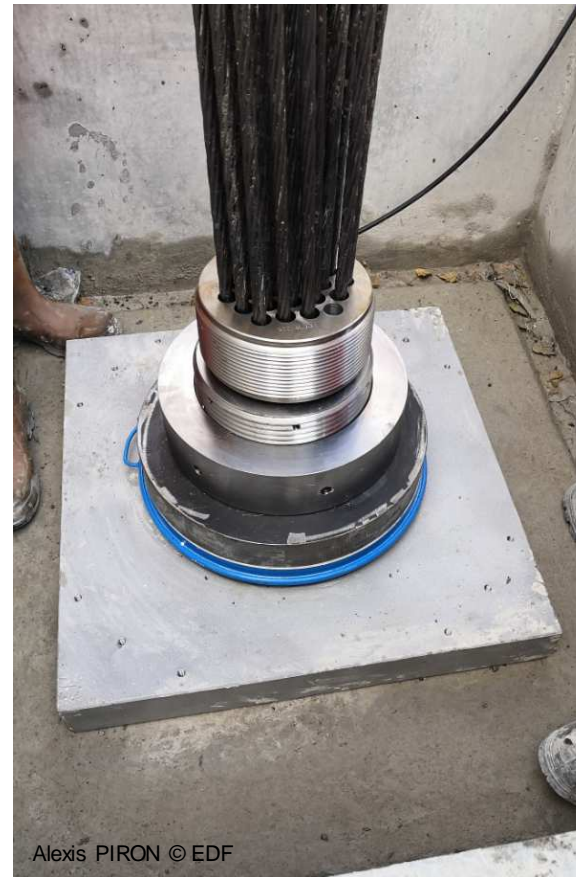
Tête démontable ne touchant pas aux clavettes
